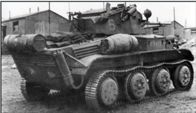
▲ en ▼ Tank T9333, met volle bepakking. Aan de loop is een Little John adapter bevestigd. De bren moest aan de buitenkant van de toren worden opgeborgen.
