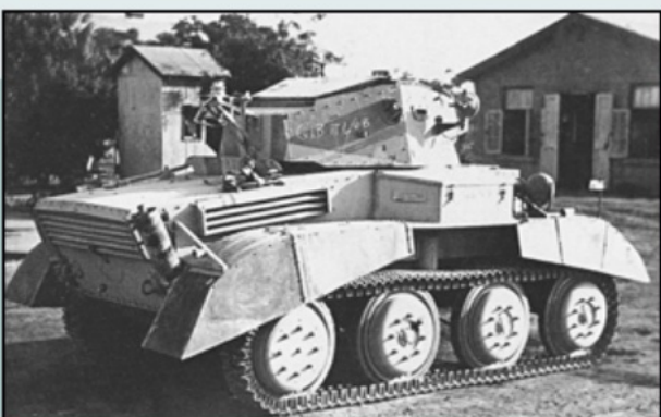
Een Tetrarch met een camouflage die doet denken aan de tanks van het 8 ste Leger in Noord-Afrika. Vanwege het koelsysteem was de tank echter niet geschikt voor inzet in warme gebieden.
